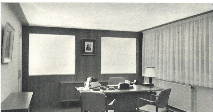
5. Bureau de direction à la Société SOCOBAC à DREUX. Plafond entièrement lumineux. Installation M. Travers Photo Boigontier
